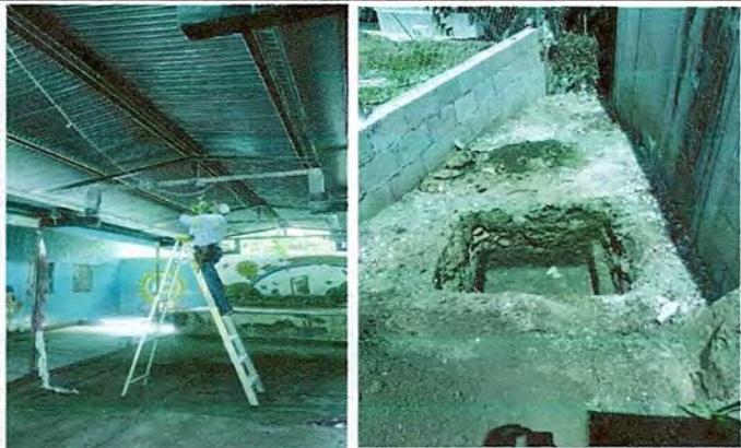
Foto 1: Se inicia con el nuevo cableado eléctrico de toda la escuela y con el mejoramiento del piso y base del tinaco.
