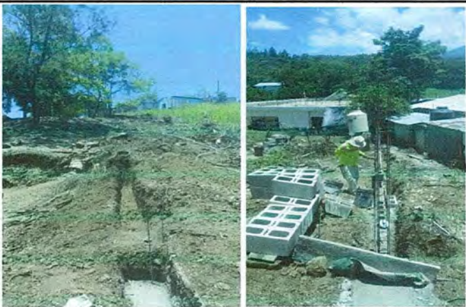
Foto 3: Trabajos realizados durante el mejoramiento de la circulación con malla atrás de la escuela.
